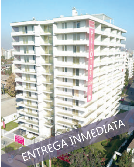
EDIFICIO LOS LEONES
