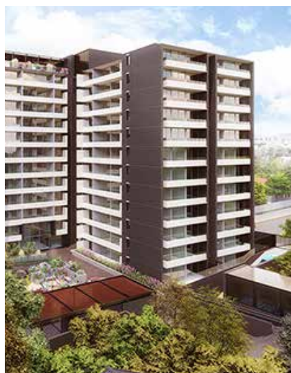
Edificio Quilín Metro Quilín
